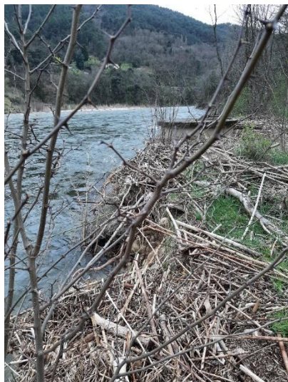
Photo 2 : Captage Les Avallons_Dunière – mars 2024
