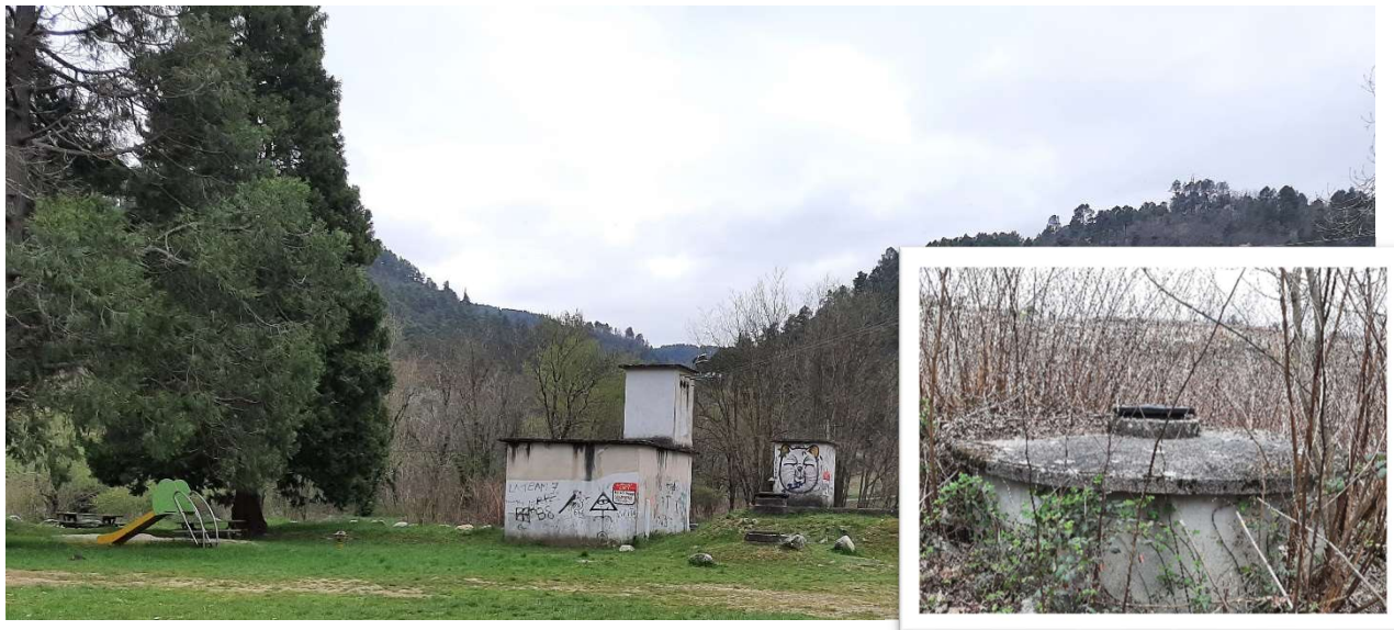
Photo 5 : Puits de Chauvert_Les Ollières
